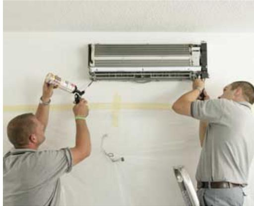
Der Filter wird eingesetzt. Abschließend erfolgt die Anbringung der Gehäuseverkleidung des Innengerätes.
