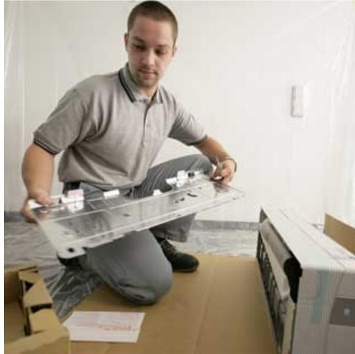
Die Anbringung des Befestigungsblechs erfolgt mittels Schrauben und Dübel. Um Schmutz zu vermeiden, wird der Staub direkt an der Bohrstelle mit einem Staubsauger abgesaugt.
